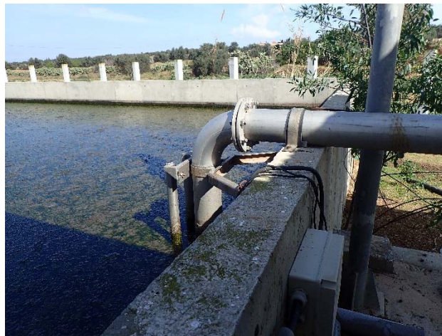
Figure 6-14 : Développement algal dans le bassin de stockage du périmètre irrigué de Ouardanine
