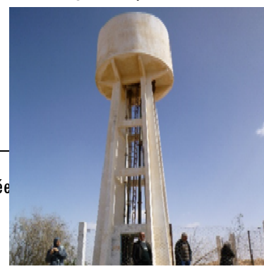
Figure 6-10 : Château d'eau du périmètre irrigué d'Ouljet El Khoder
